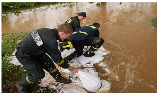
Fot.2. Długotrwała praca podczas budowania wałów (fot. K. Przybylski)
